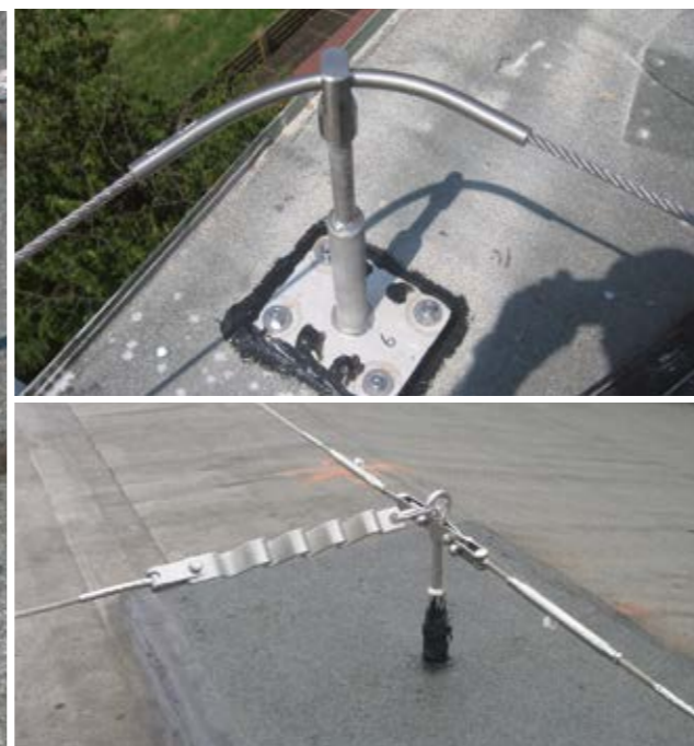
Tendit. F/F - F/C Tenditore corto per tensionamento fune
